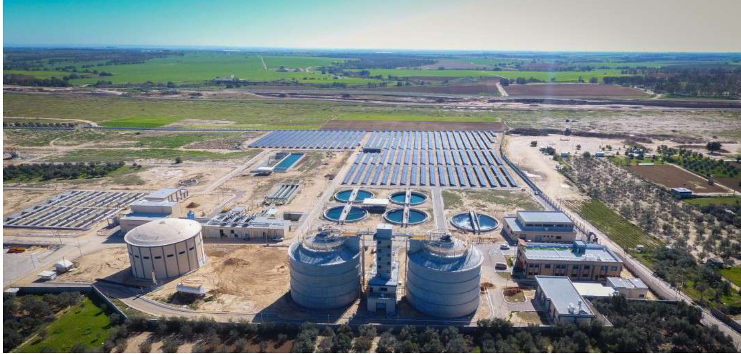
في غزة محطة معالجة مياه الصرف الصحي
