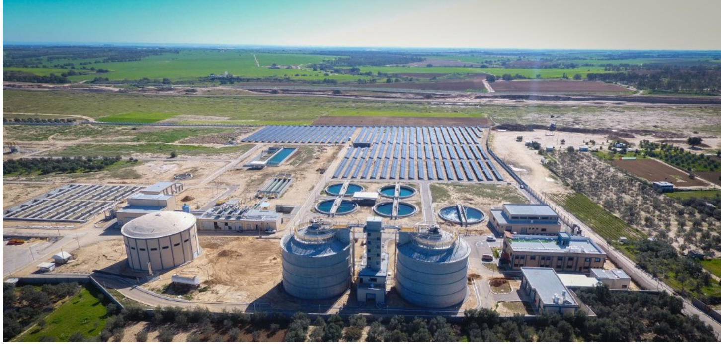
في غزة محطة معالجة مياه الصرف الصحي
