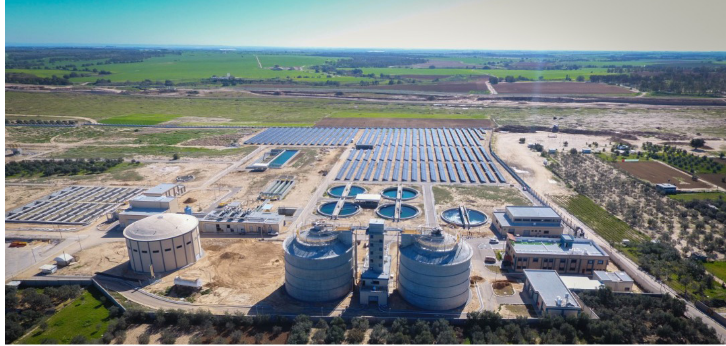
في غزة محطة معالجة مياه الصرف الصحي
